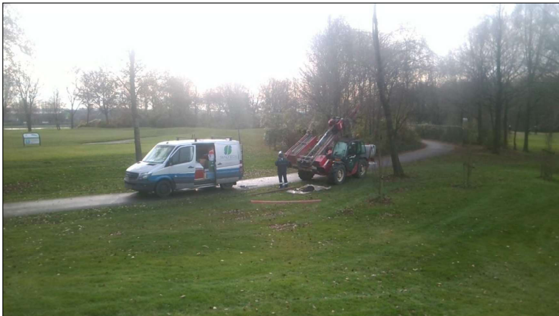
Figuur 3: Mechanische sonische boorstelling (Manitou)
