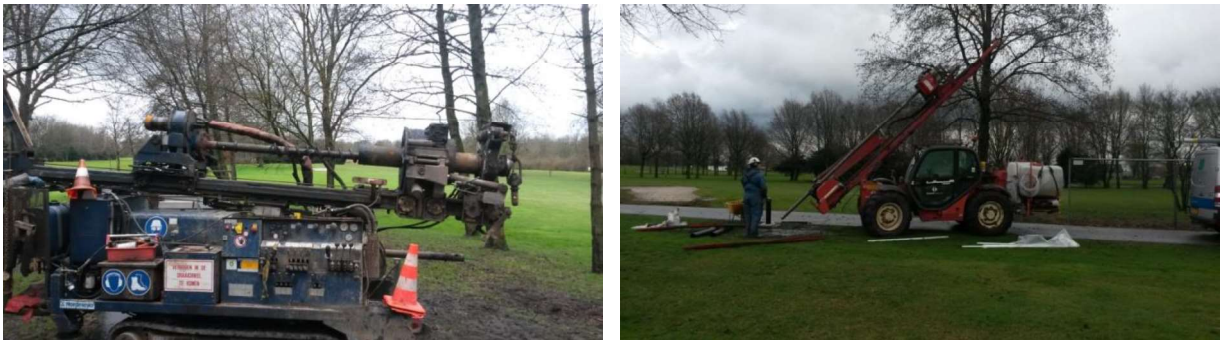
Figuur 5: Avegaarboor (links) en sonische boorstelling (rechts)
