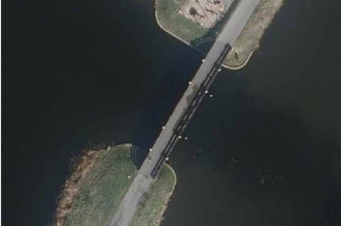
Afbeelding 5.9 Geen kabels en leidingen zichtbaar bij de zuidoostelijke boezem
