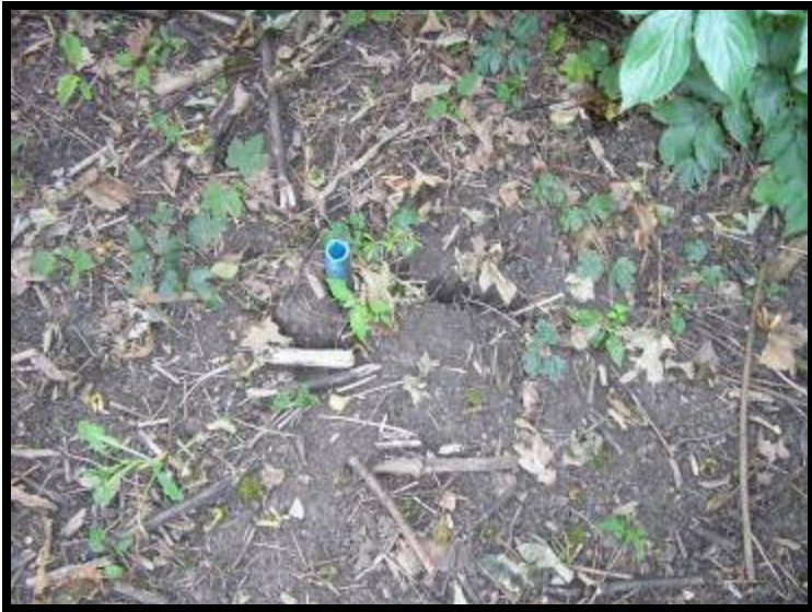
Forse scheuren in de leeflaag op het bovenvlak ter plaatse van de heesteren
