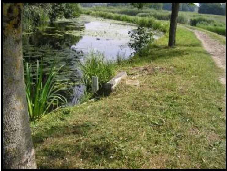
Uitlaat Kromme Aar in oostelijke richting
