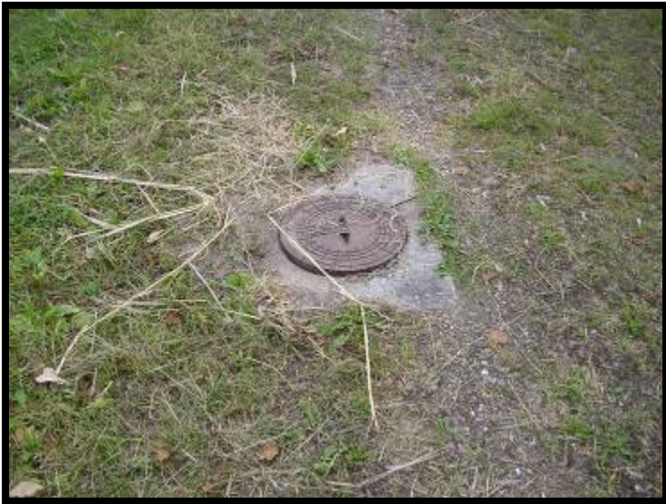
Doorspuitvoorziening in de ringdrainage nabij de sloot Heemgebied. De meeste deksels van deze voorzieningen
