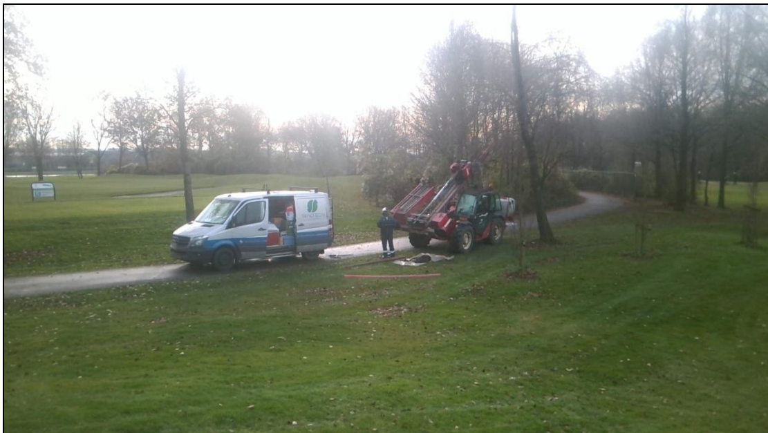
Figuur 3: Mechanische sonische boorstelling (Manitou)
