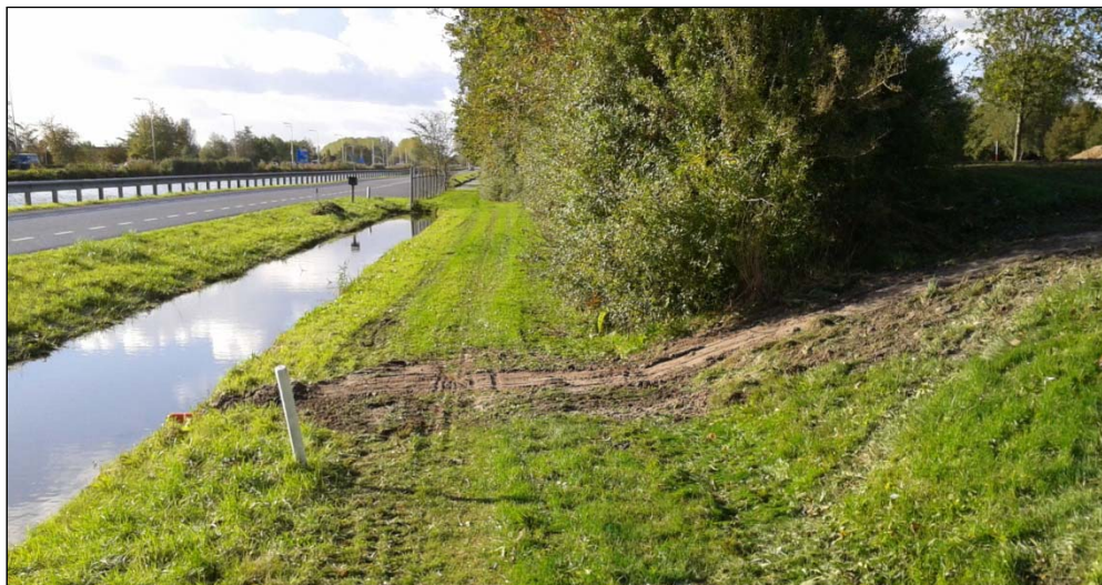
Figuur 17: Doorgraven deklaag ter hoogte van DDP Aarkanaal
