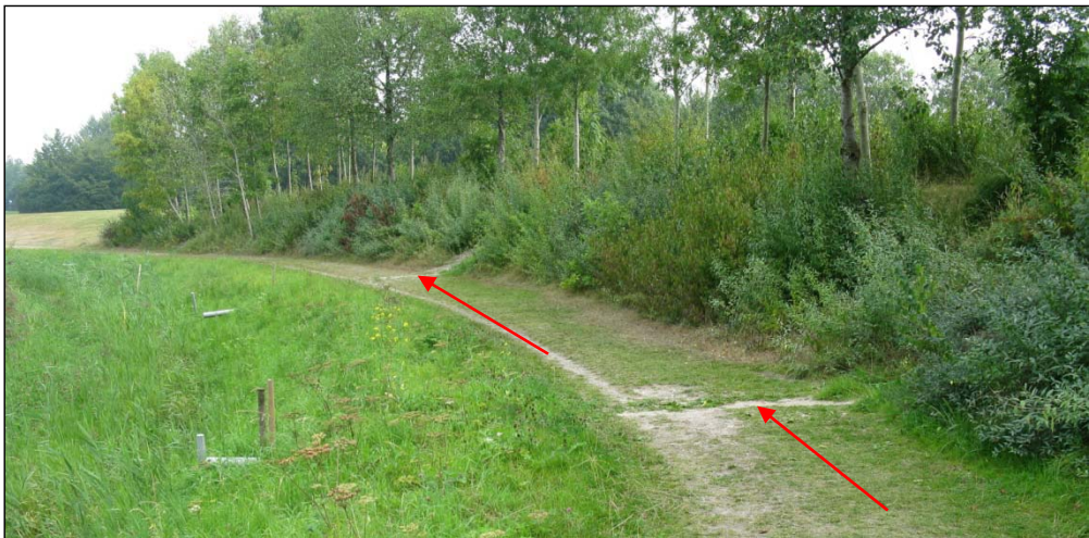
Figuur 16: Doorgraven deklaag ter hoogte van doorspuitvoorziening 12
