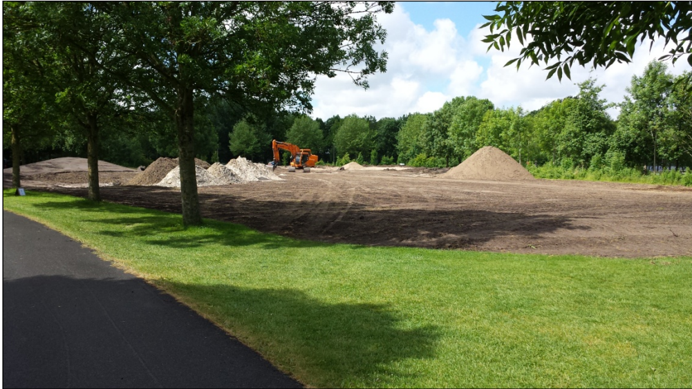
Figuur 14: Werkzaamheden bij green hole 11
