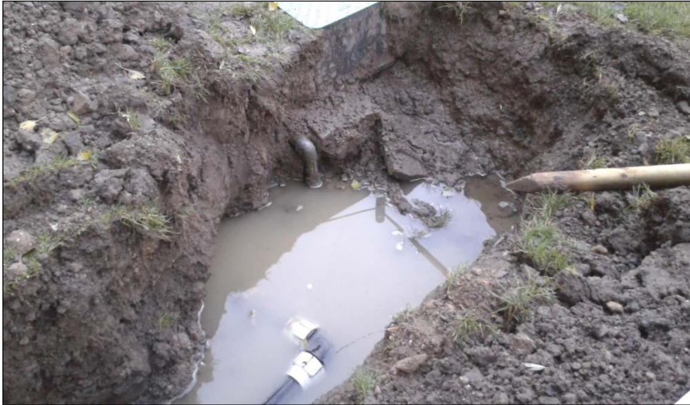
Figuur 15: Graafwerkzaamheden ten behoeve van beregeningsinstallatie ter hoogte van doorspuitvoorziening 19
