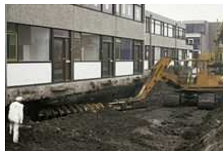
Speciale graafmachine aan het werk.
