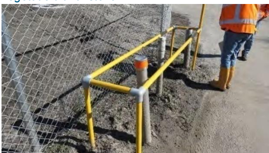
Figuur 4.1 Beschermkokers voorzien van stalen anti-maai/aanrijd constructie met hoge buis die boven de toekomstige vegetatie uit zal steken.
