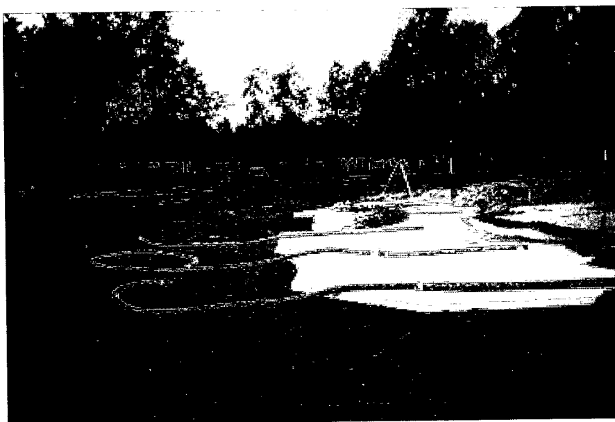
Foto 2: aanbrengen tempexplaten en drainage
