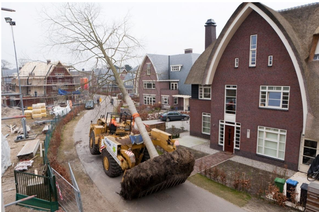
Afbeelding 23: transport van een boom met zware kluit met een grote verplantschap.
